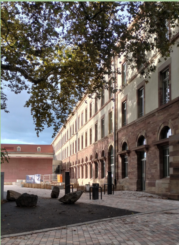
La Manufacture des Tabacs, nouvelle extension de l'école Photo : © Agathe Perrenoud
